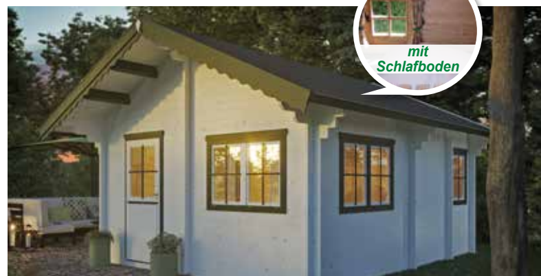
Abb. bauseits farbbehandelt
